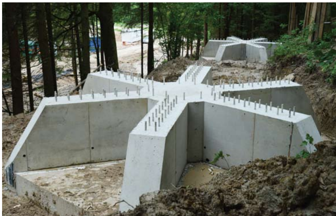
Lajų tako maštakai: viršuje - matoma pamatų dalis, po žeme – dar 6 metrai.
